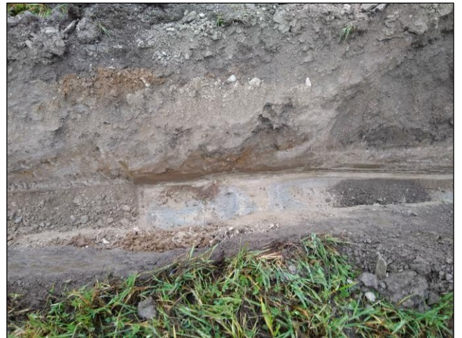
Saviselle pellolle kaivettua maakaapeliojaa.
