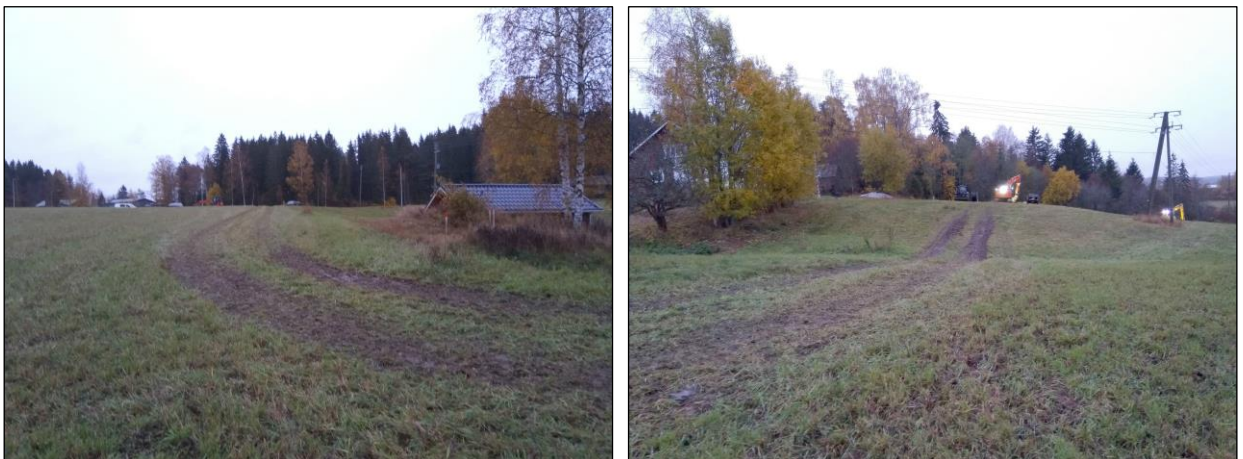
Maakaapelilinjan reittiä pellolla ennen kaivamista.
