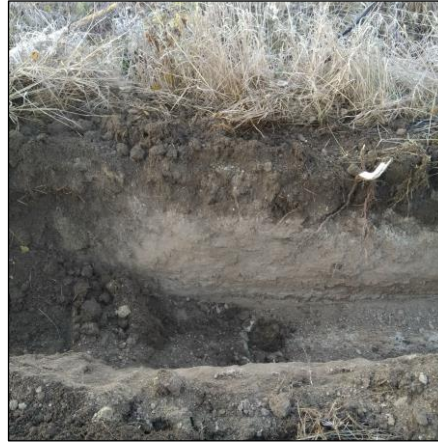
Vasemmalla maakaapeliojan reittiä peltoalueella, ennen kaivamista. Oikealla kaivetun ojan seinämää. Näkyvissä muokauskerros, jonka alla savi.
