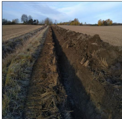
Pellon poikki kaivettu maakaapelilinja.
